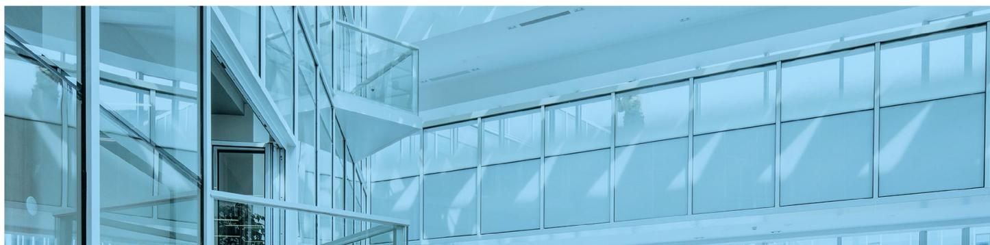
热反射镀膜玻璃，又称阳光控制膜玻璃，是在浮法玻璃表面用真空磁控溅射的方法镀上特定的膜层。薄膜的主要功能是按需要的比例控制太阳直接辐射的反射、透过和吸收，并产生需要的反射颜色。热反射镀膜玻璃具有极佳的装饰效果，同事对室内物体和建筑构件具有良好视线遮蔽功能。
